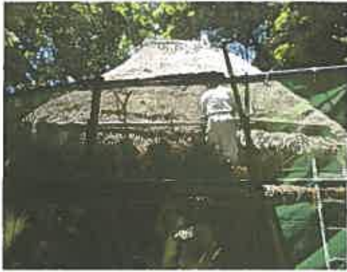
茅葺き屋根の葺き替え
